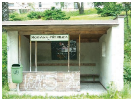
Rekonstrukce zastávky – Přehrada
