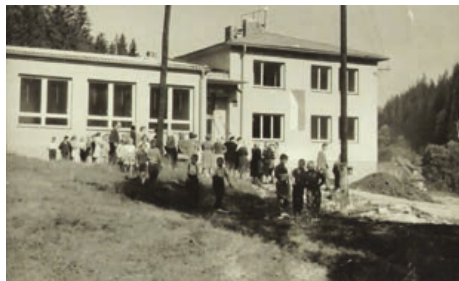
Nová školní budova v Lúčce
