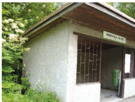
Rekonstrukce zastávky – Slavíč
